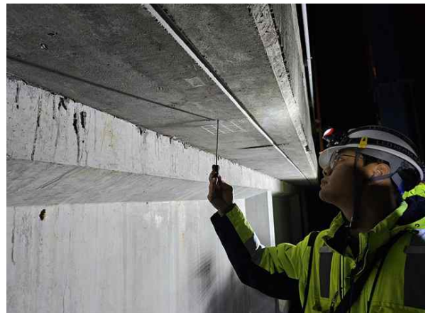
탄산화깊이 측정 현황
